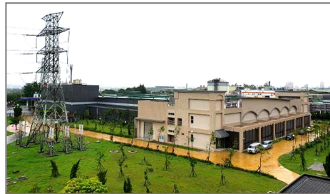
圖 1. 新 69kV 開關場建築物
