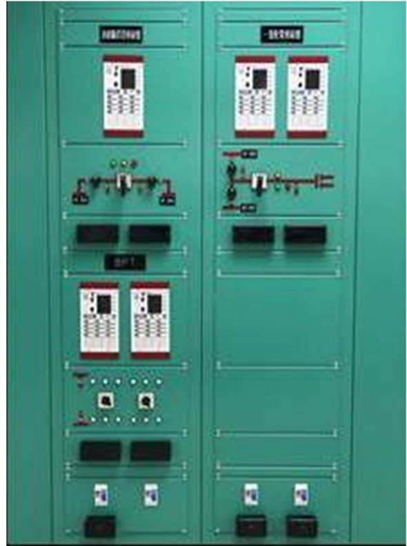
圖 3 檔位控制模組盤示意圖
