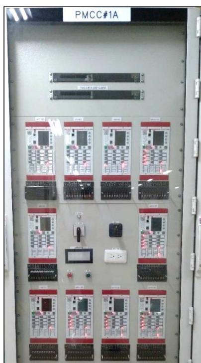
圖6-1 保定D/S IEC61850電驛盤面
