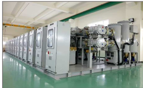
圖 2. 新 69kV G. I. S. 設備一套
