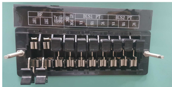
圖 3 B90 匯流排保護電驛盤 1BT 及 2BT 位置圖
