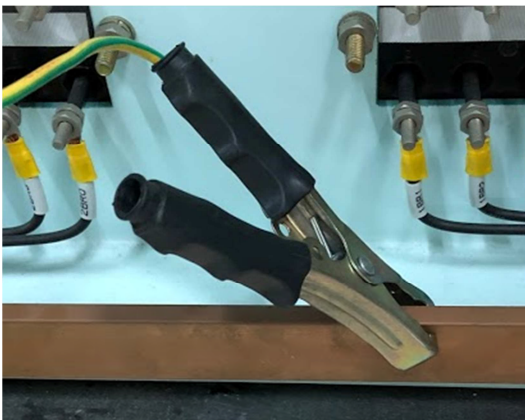
圖10 Megger SMRT36電驛測試裝置接地
