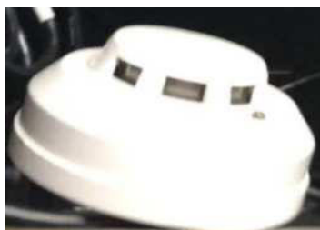
圖 8 智慧配電櫃偵煙感測器圖
