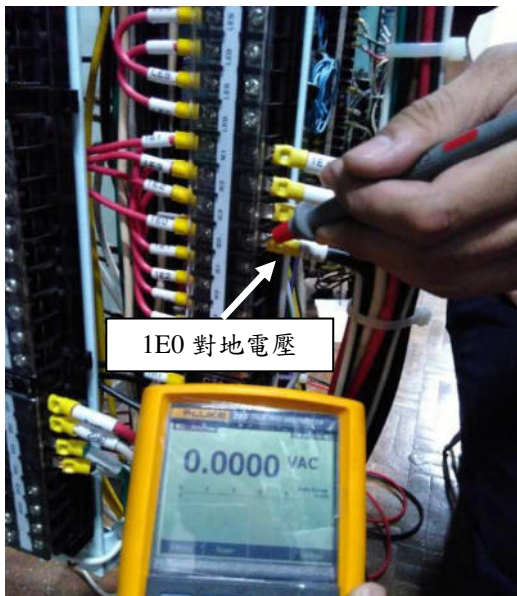
圖 6 重新量測1E0對地電壓為0V
