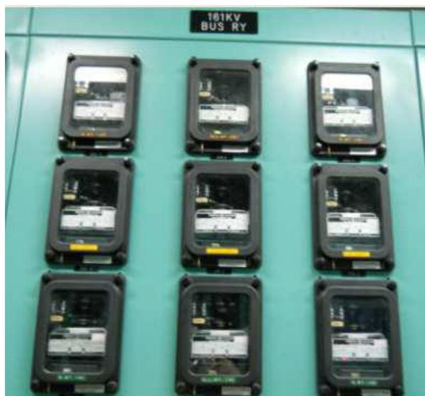
圖 1 台電公司使用中的低阻抗匯流排差動保護電驛外觀
