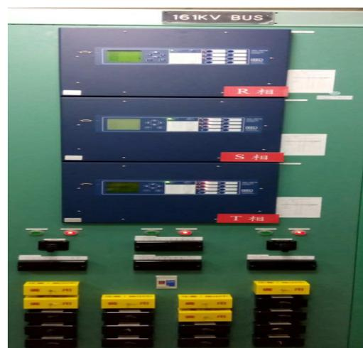
圖3. 台電公司目前使用中的SEL-487B 電驛外觀
