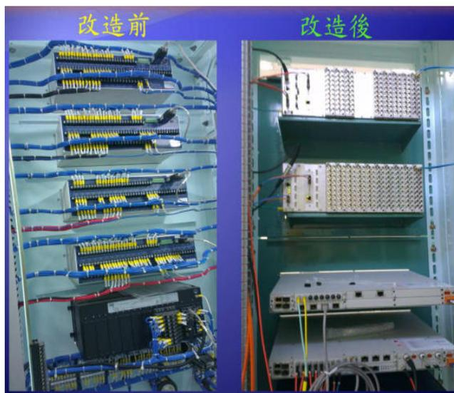
圖3 傳統數位電驛盤與IEC 61850電驛盤之比較
