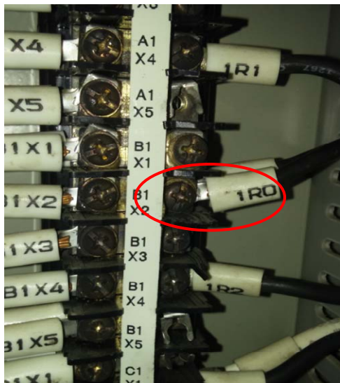
圖 8 舊有 1R0 端子部分螺絲已滑牙鬆脫
