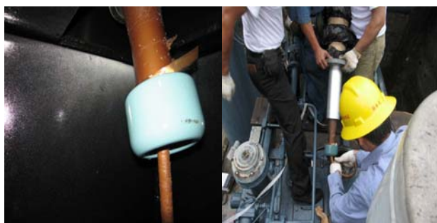
圖 2 #1 主變壓器 T 相套管下磁套故障
