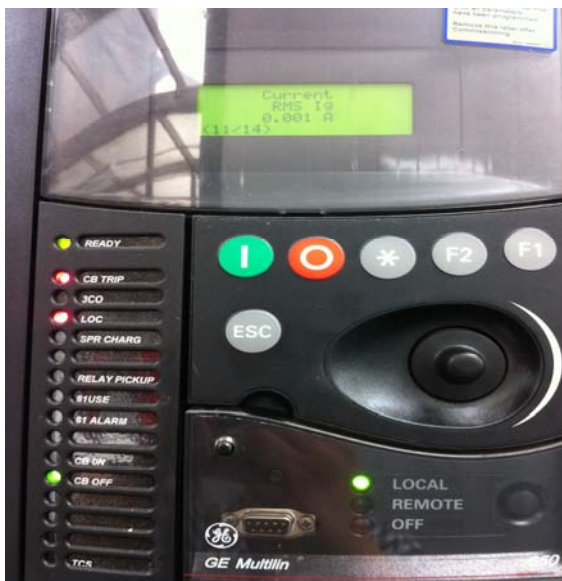
圖 37 電驛 LOC 動作，面板燈號指示
