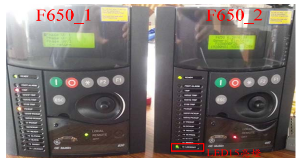
圖 26 F650_1 欠壓元件動作
