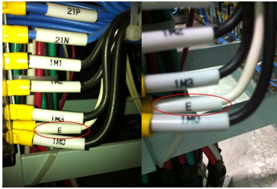
(a) GIS 現場 (b) 控制室遙控盤 圖 33 GIS 現場及遙控盤多重接地實地相片
