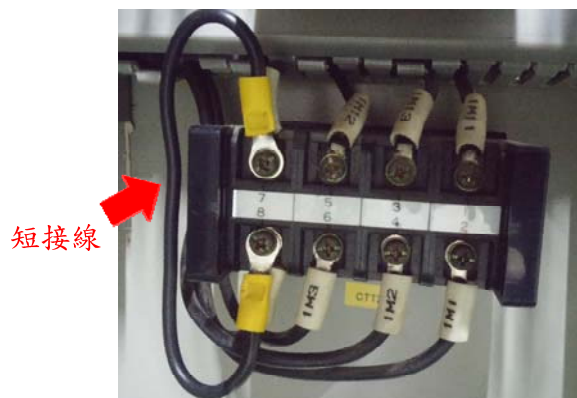
圖 29 將 CTT N 相上下方短路，目的為防止 CTT 隔開時 N 相無接地
