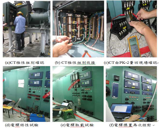
圖 9 CT 極性確認電驛特性、取載、標置下載試驗圖
