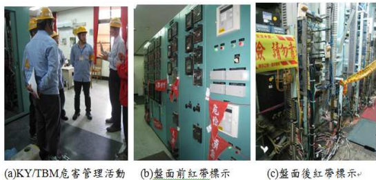
圖 7 工作前做 KY/TBM 危害管理活動及盤面紅藍帶標示圖
