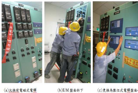
圖 3 變壓器電驛盤汰換前、後比較圖
