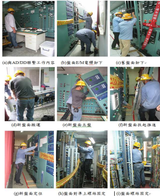
圖 8 新舊盤面更換定位工作程序圖
