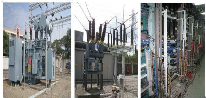
圖 4 變壓器電驛盤面汰換相關設備圖
