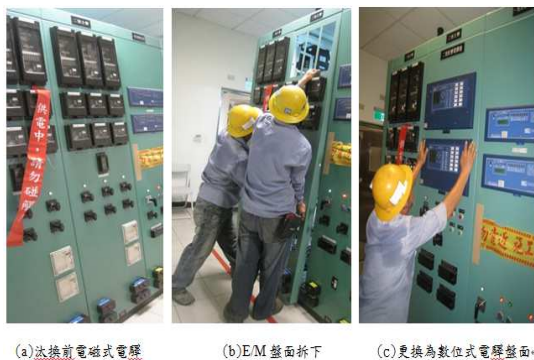
圖 3 變壓器電驛盤汰換前、後比較圖
