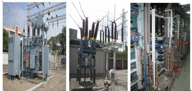
(a) 汰換檢視接線與變壓器 (b) 汰換檢視接線與斷路器 (c) 汰換盤面空間尺寸
