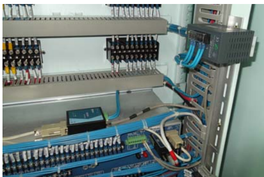
圖 3 現場安裝照片
