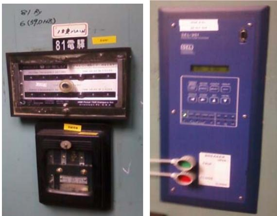
圖二十三 汰換前、後81 Relay盤面圖
