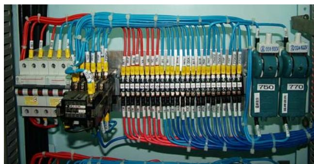
圖二十一 低頻電驛輔助控制盤
