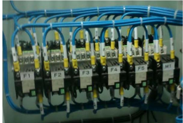
圖十四 控制低頻電驛是否啟用之栓鎖電驛
