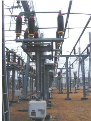
圖 2(a) 現場屋外開放式匯流排
