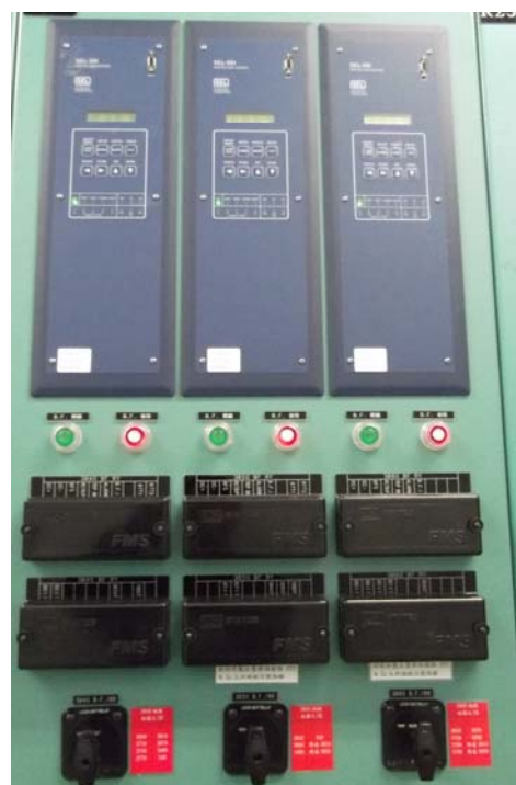
圖 5 汰換後 B.F. Relay 盤面
