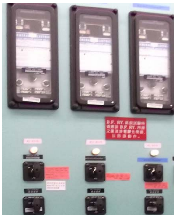
圖 4 汰換前 B.F. Relay 盤面
