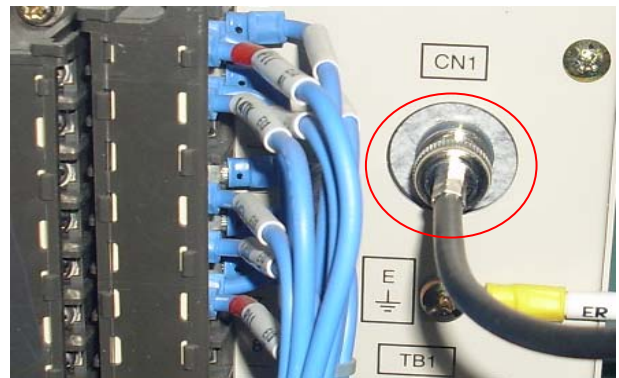
圖 5 GRZ100/GRL100 保護電驛之 BNC 接頭圖
