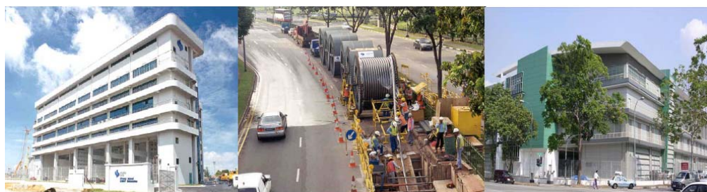
圖 8 光纖與電纜同時電纜鋪設
