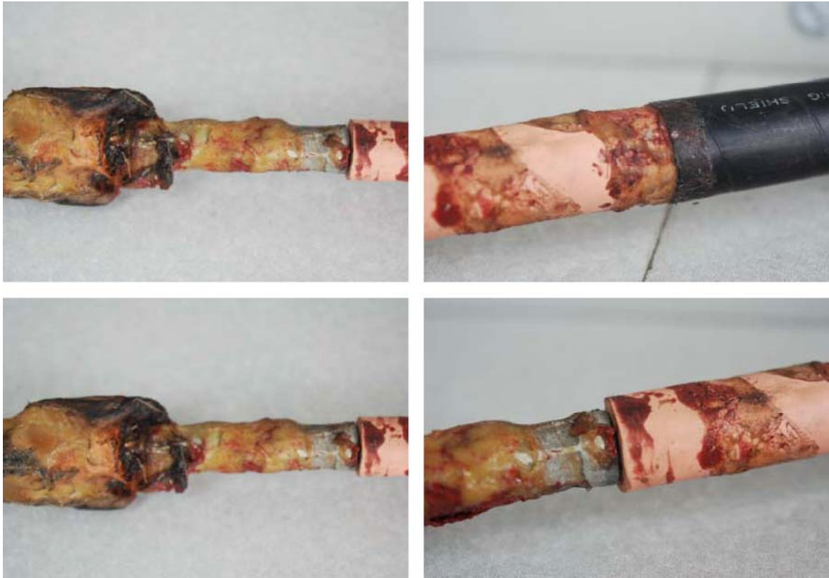
圖 10 EPR 電纜直路接續匣工法不良
