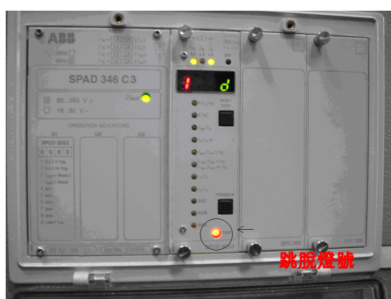
圖 30 保護電驛之現場測試輸入波形及跳脫訊號
